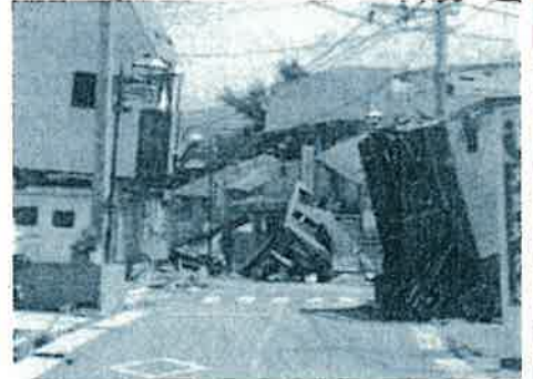
地震で損壊した建物
