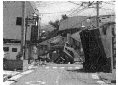
地震で損壊した建物
